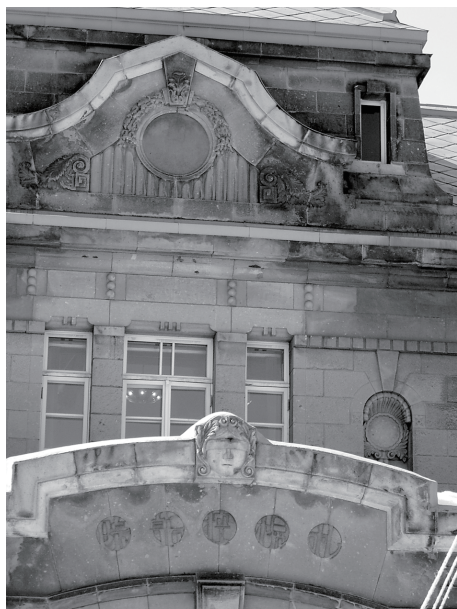
図5 「旧札幌控訴院（現札幌市資料館）正面」 下方の目隠しされたユスティアの顔 とその上方の戦後菊花紋を削り落として できた円形の痕跡
